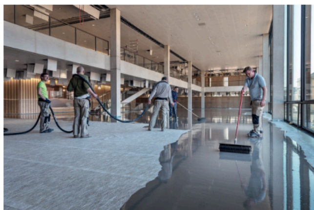
Přestěrkování UZIN RR 201 stěrkovací hmotou UZIN NC 160 s pomocí čerpací techniky
