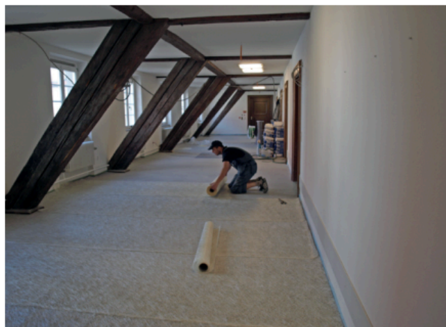
Plošné uložení rohože UZIN RR 201 na podklad, který je sanován
