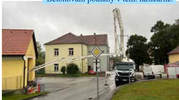
Betonování podlahy v tem. hasičárně.
