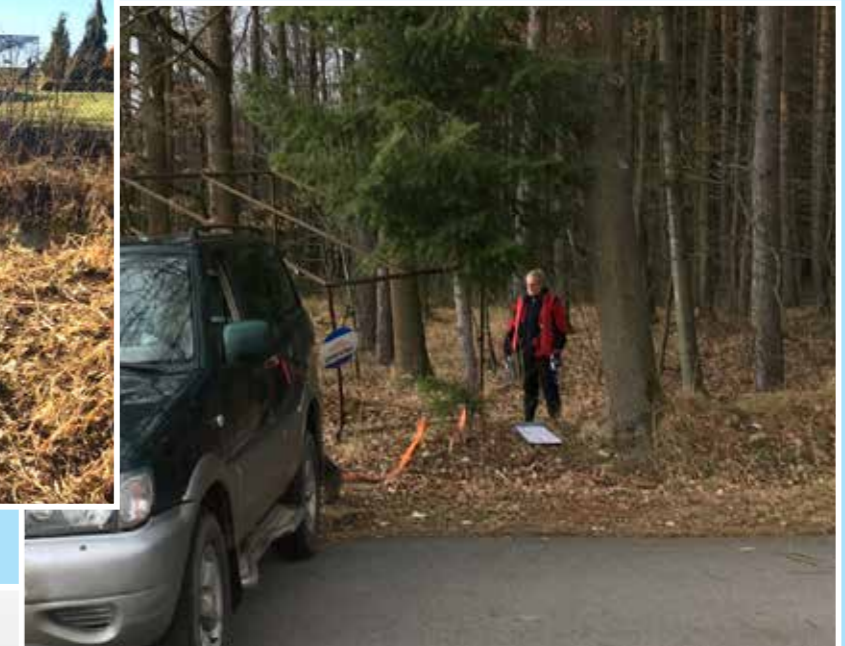
Práce na autobusové čekárně Pláňovy Karlem Bláhou
