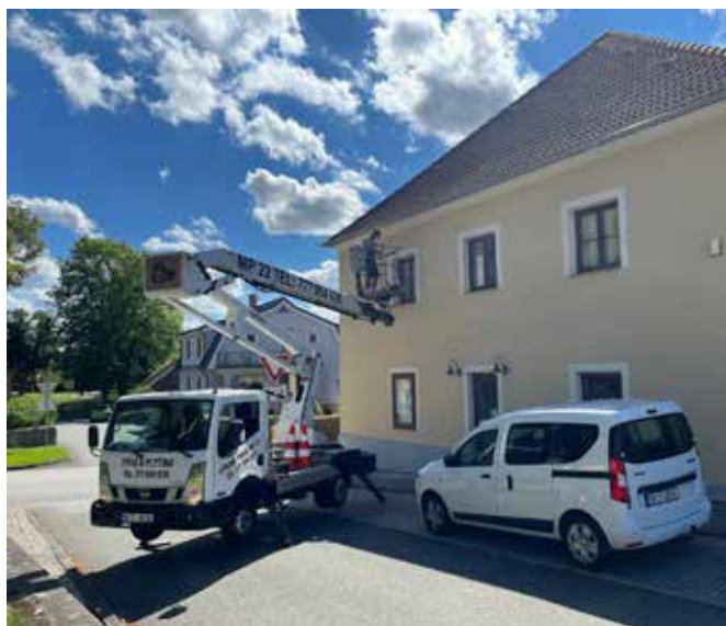
Plošinář Jirka instaluje na temelínské čp. 15 sádrový terčík pro monitorování trhlin
