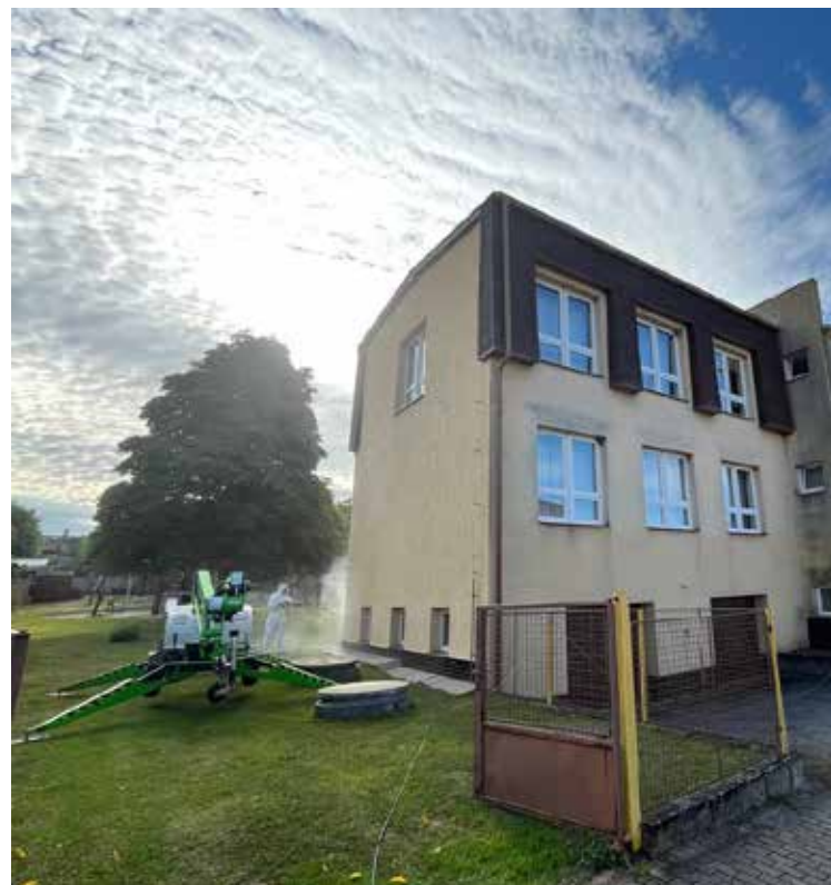
Chemické čištění fasády školy
