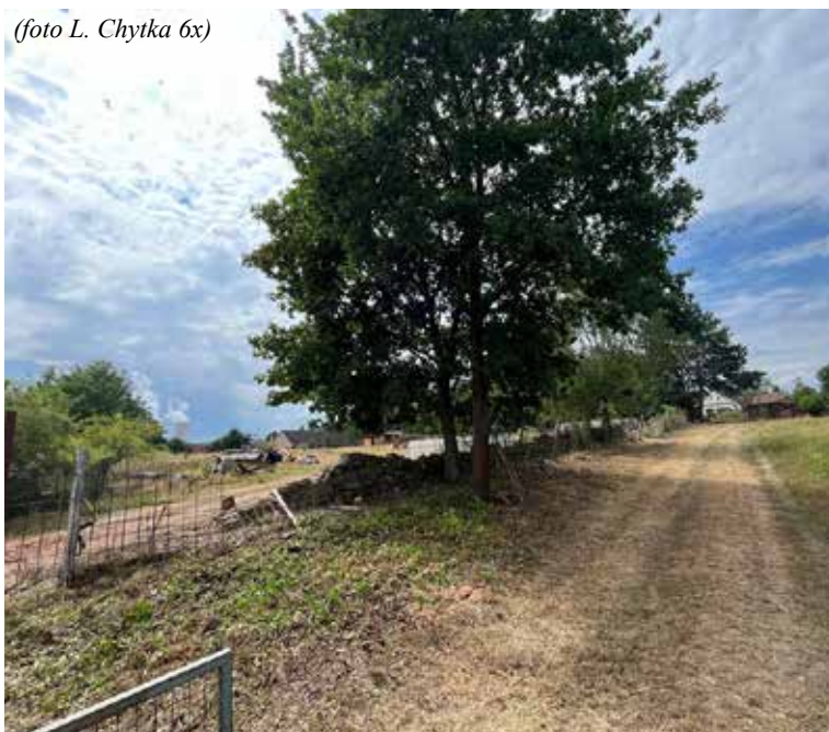
Vyčištěný pozemek pro vybudování cesty ve Zvěrkovicích (vlevo od vyjetých kolejí)
