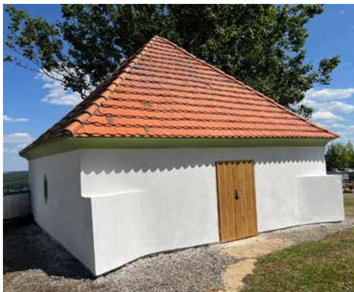
Opravená fasáda křténovské márnice s novými dveřmi
