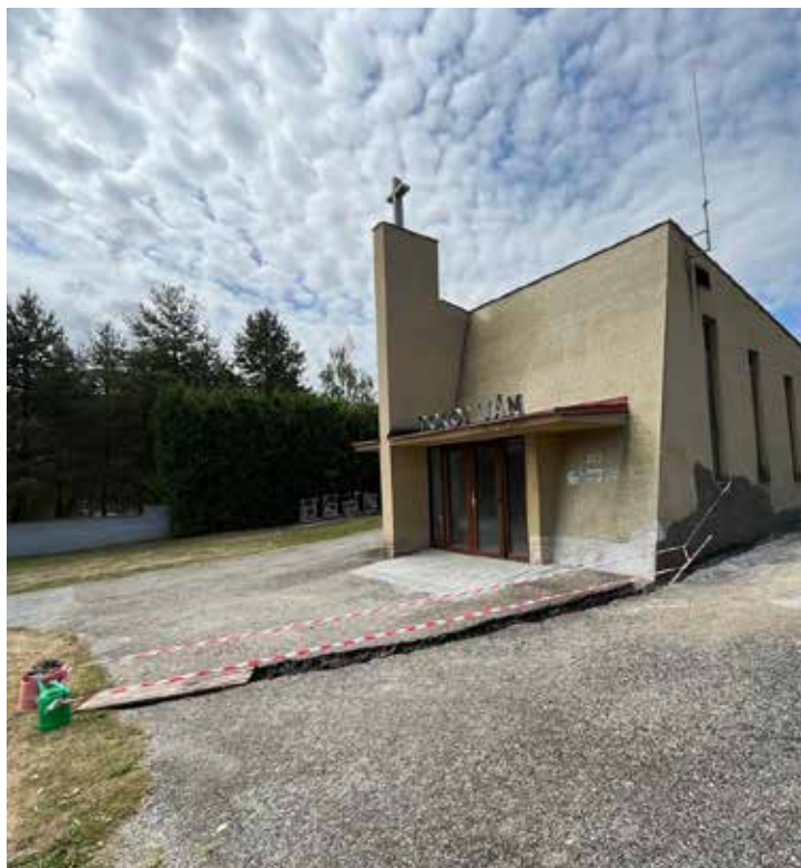
Odvodnění obřadní síně ve Křténově
