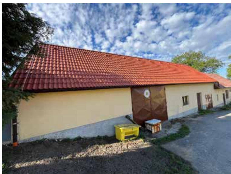
Opravená zbrojnice v Kočíně
