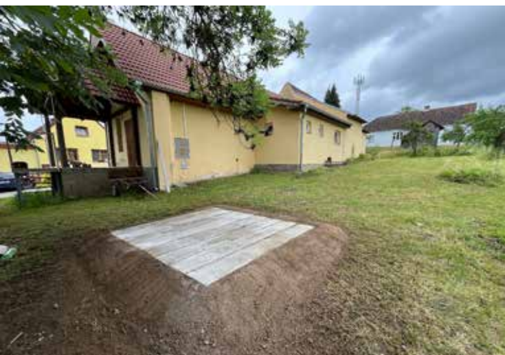
Nově překrytý propadlý septik za býv. obchodem v Kočíně
