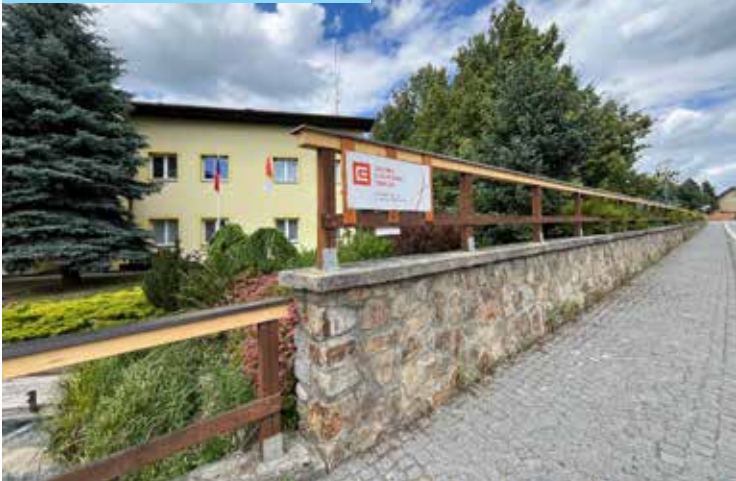
Opravené zábradlí před OÚ
